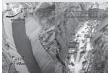
تصویری از حوضچه آرامش سد کارون ۳ در زمان اجرا و اتمام پروژه
